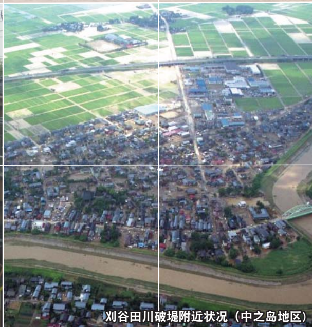
住宅区浸水被害时的实例（中之岛地区）
